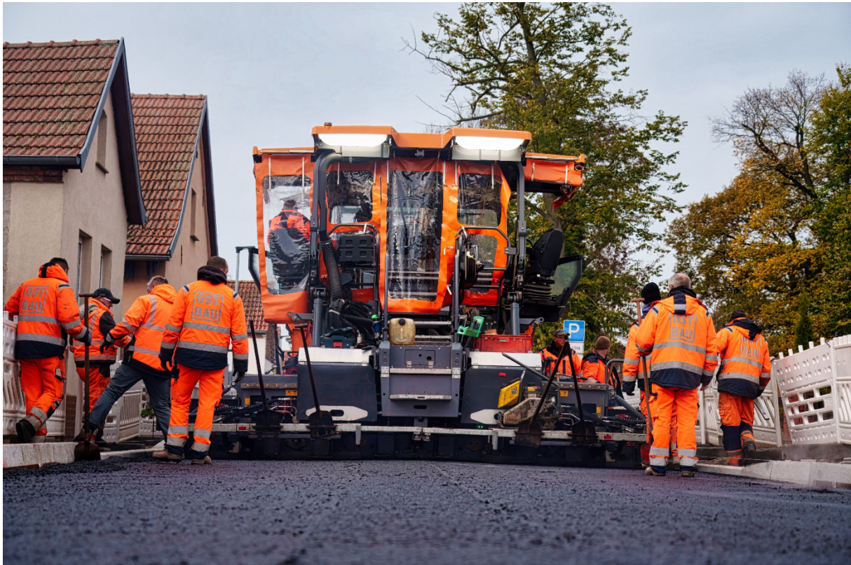
Foto © OST BAU (2024): Straßenbau-Kolonne von OST BAU bei den Asphaltarbeiten in Lüderitz
