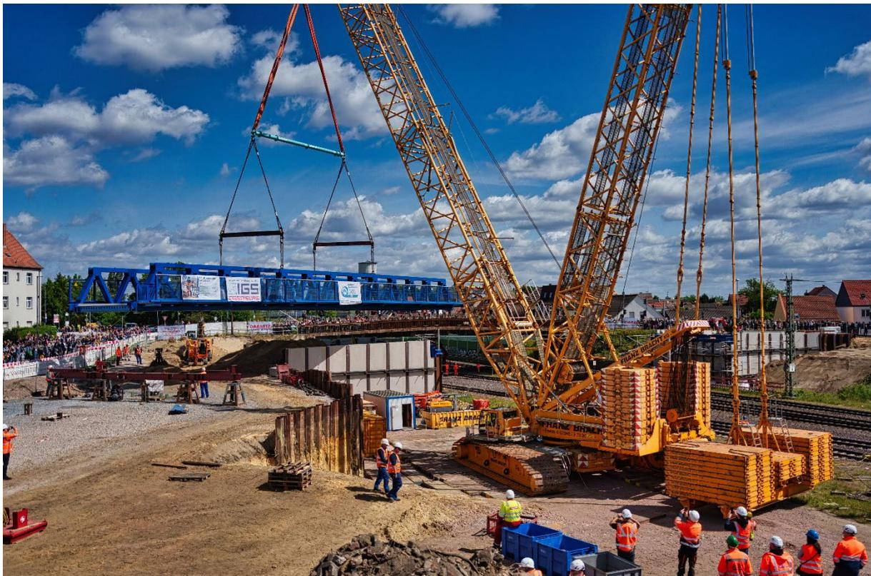
Foto ©OST BAU (2025): Brückeneinhub an der Zerbster Brücke
