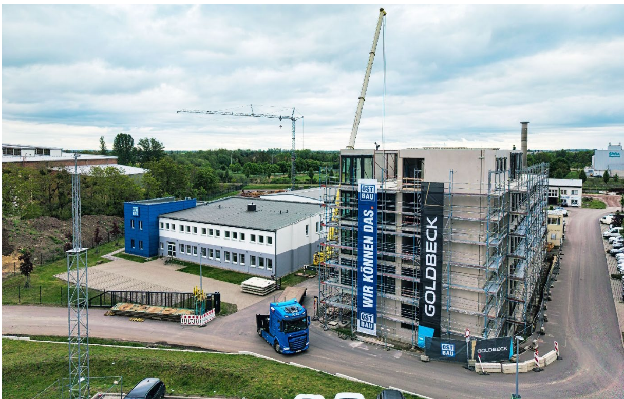
Foto: ©OST BAU (2026): Baufortschritt des Büroneubaus in der Berliner Chaussee 100 in Magdeburg
